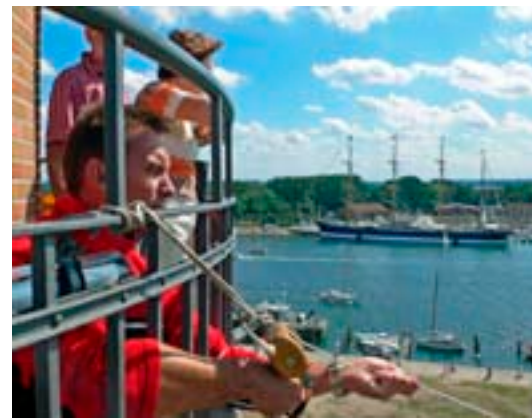
Jürgen Schmeckebeier bei Arbeiten an der Antenne oben auf dem Leuchtturm. Foto: DK9HU, Karl-Erhard Vögele
